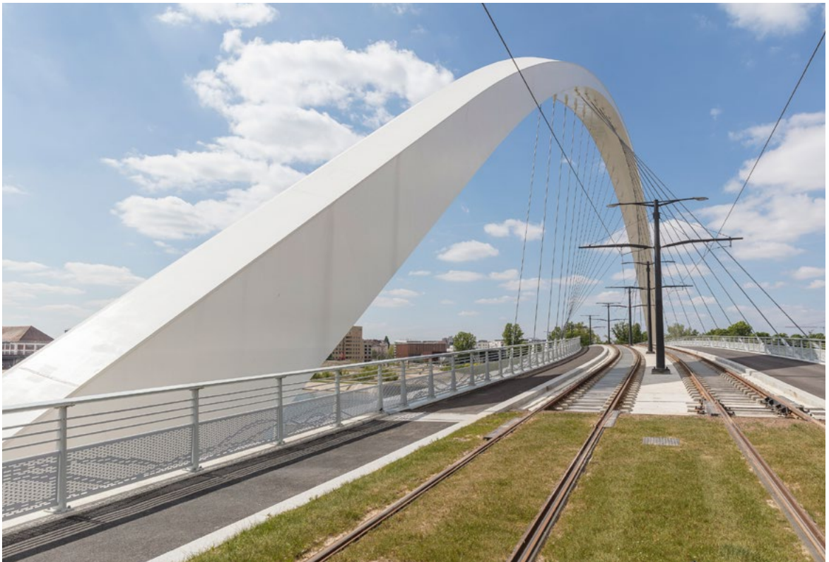
Die neue Trambrücke „Pont Citadelle“ spannt sich elegant über das Vauban-Becken in Straßburg.
