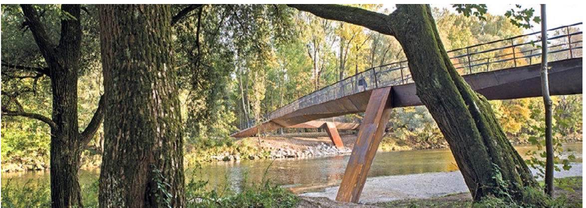
Die Fußgängerbrücke „Isarsteg Nord“ aus wetterfestem Baustahl wurde 2018 mit dem Stahl-Innovationspreis ausgezeichnet.
