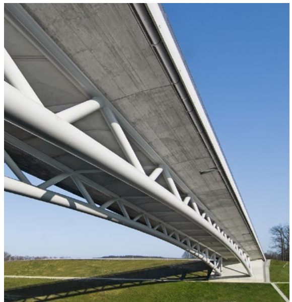
Autobahnbrücke mit geschweißten Rohrprofilen
