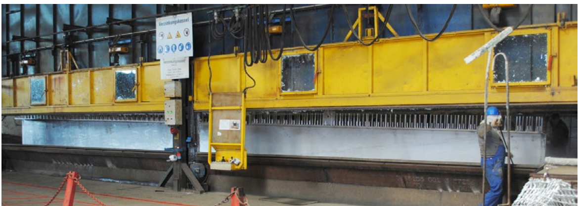
Verzinkung des Brückenträgers für die A44
