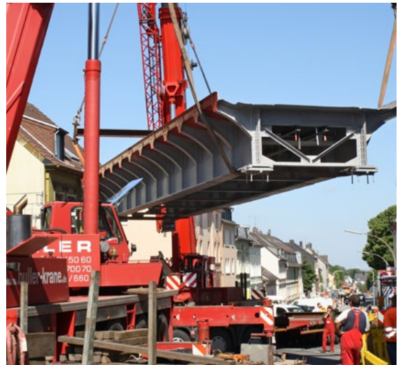
Einheben einer sanierten Eisenbahnbrücke in Velbert
