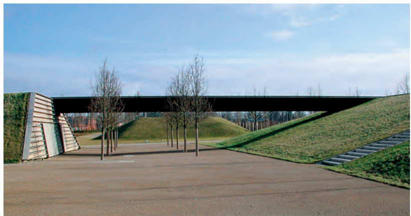
Abb. 32: Fußgängerbrücke am Kiosk, Potsdam
