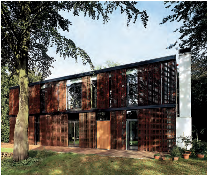
Abb. 20: Westfassade mit stockwerkshohen, verschiebbaren Sonnenschutzelementen mit Gitterstruktur aus Wetterfestem Stahl
