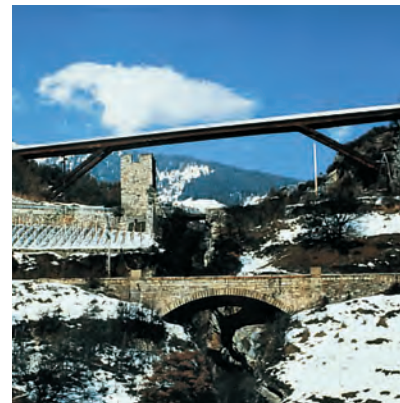
Abb. 36: Dalabrücke, Rahmenbrücke mit geneigten Stielen
