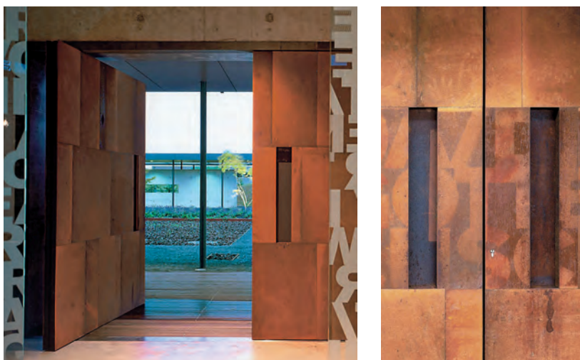
Abb. 30: Zweiflügelige Eingangstür der Kirche: Ansicht von innen und Detail von außen im Bereich der Tür(ein)griffe
