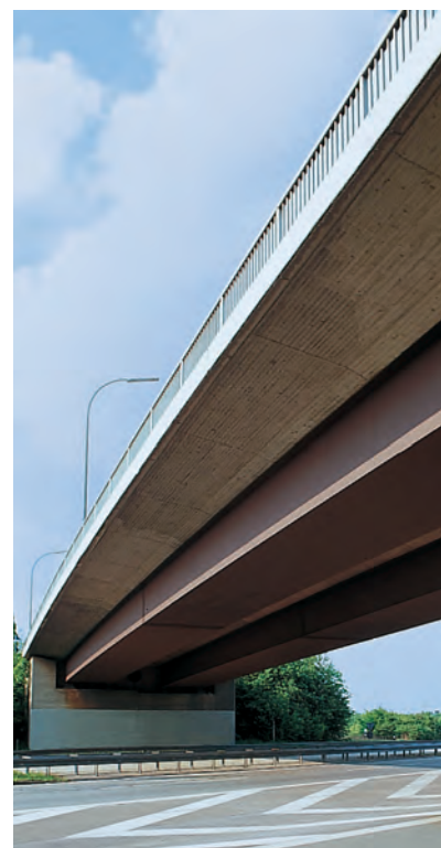
Abb. 43: Rüschelbrinkbrücke, Endfeld über der Brackeler Straße, Dortmund
