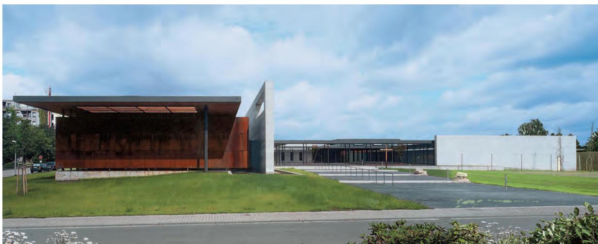
Abb. 27: Gemeindezentrum Herz Jesu in Völklingen-Ludweiler. Links von der hohen Betonscheibe ist die Kirche angeordnet. Die Sichtflächen der Frontwand (im Bild zu sehen) und der linken Seitenwand bestehen außen und innen aus Wetterfestem Stahl.
