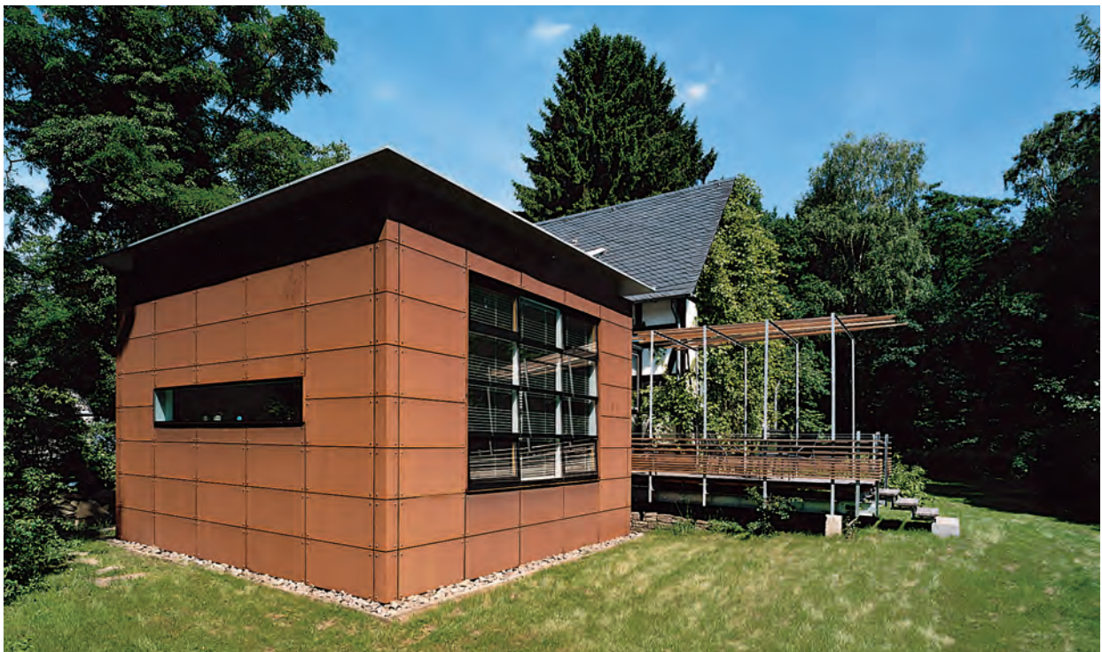
Abb. 23: Fachwerkhausanbau mit Fassadenplatten aus Wetterfestem Stahl
