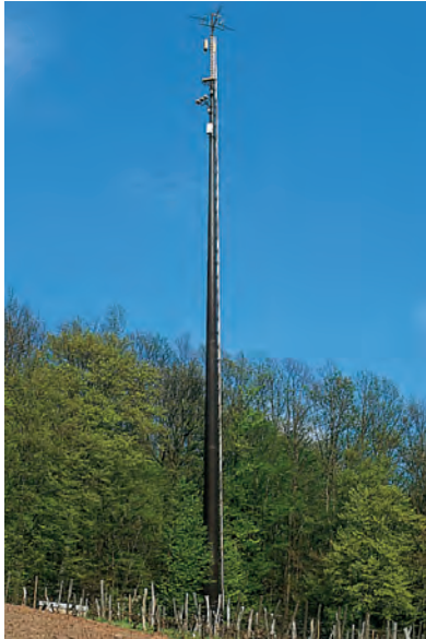
Abb. 44: Fernsehumschalter. Etwa 100 Exemplare wurden von der Post um 1980 gebaut. Höhe zwischen 60 und 70 m, Blechdicke des Rohrquerschnitts 10 bis 15 mm.
