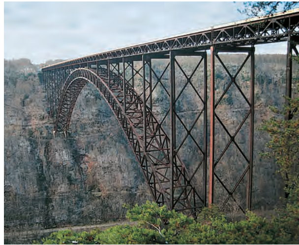
Abb. 3: New-River-Gorge Brücke in West Virginia, USA, Spannweite 518 m
