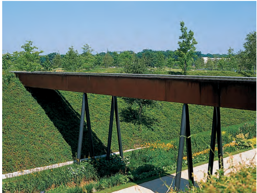
Abb. 31: Brücke mit Zwischenstützen
